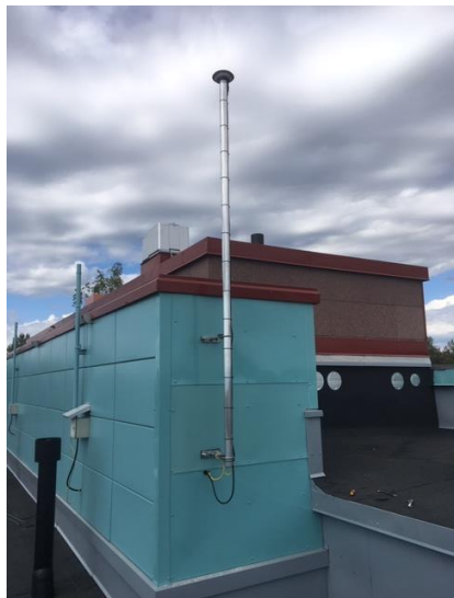
Antennin kiinnitys esimerkkejä
