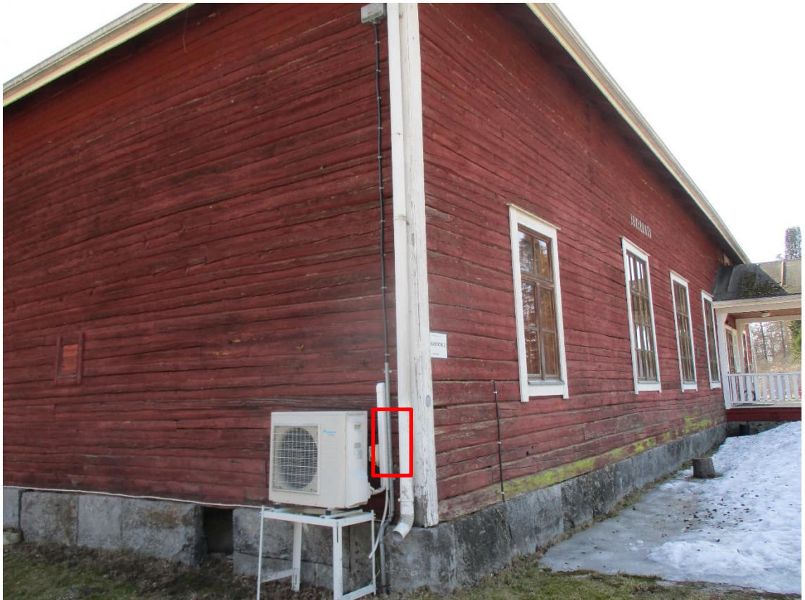
Kuva 7 Idän puoleisessa päädyssä on nurkkasalvoksen yhteydessä vaurioitunut hirsikerrat 3 ja 5.
