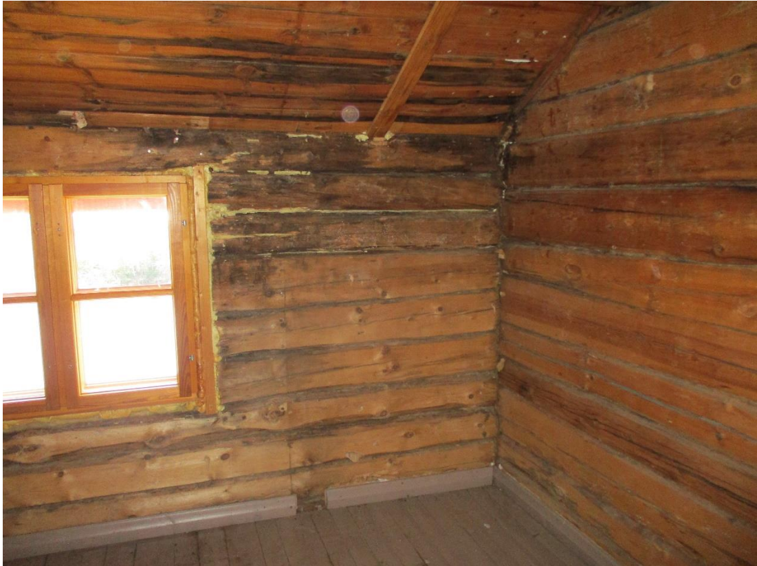
Kuva 2 Vaurioita on noin viidessä hirsikerrassa vajaan kahden metrin matkalla eli vaihdettavia sekä paikattavia hirsiiä on noin 8-10 juoksumetriä. Vesikatteen kunnostamisen yhteydessä poistetaan eristetyn vinosuuntaisen kattolapteen kastuneet lämmöneristeet sekä tuetaan kattotuolin vaurioitunut yläparre lapalankuilla.
