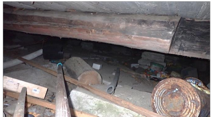
4. Ryömintätilaa eteläsivulla, ei rakennevaurioita, jätettä.
