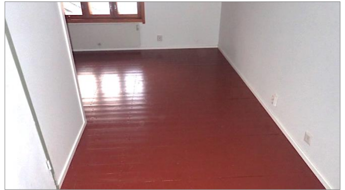
4. Asunnon lattiat uusittu kosteusvauriokorjauksessa.
