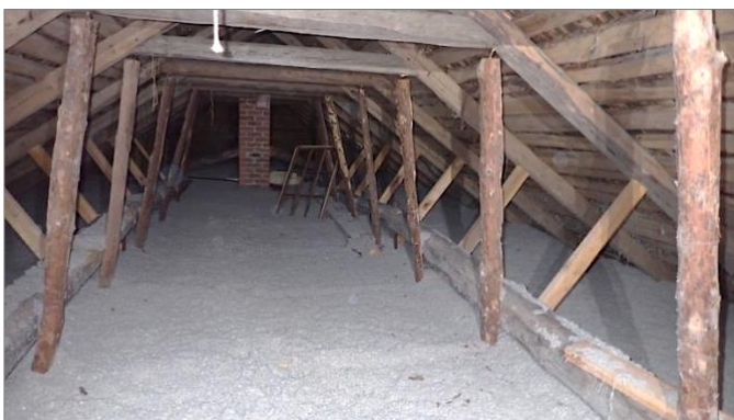
1. Yläpohjan yleiskuvaa, lisäeristetty puhallusvillalla.
