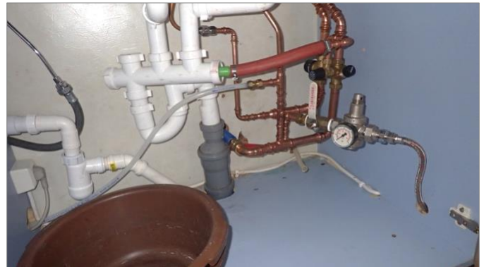
2. Keittiön vesipisteen vesi- ja viemäriasennukset.
