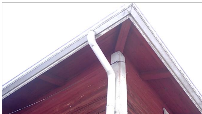
1. Kourut ja syöksytorvet tyydyttävässä kunnossa.
