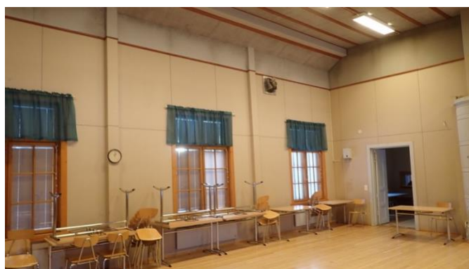
2. Seinäpinnat lievästi likaantuneet, ei vaurioita.
