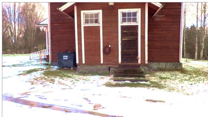
3. Maanpinnat kallistuvat loivasti ulospäin rakenteilta.
