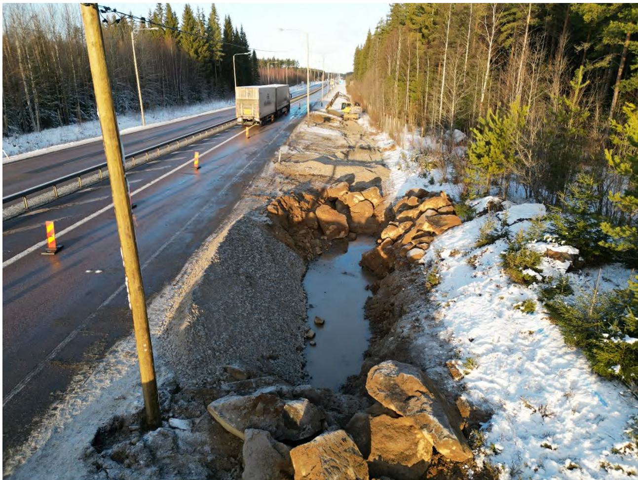
Kuva 5 Onnettomuusalueen kaivanto. Kunnostusta oltiin jatkamassa vielä kuvassa kaivannon oikealta reunalta. Ojan alueen täyttäminen on käynnissä. Kuva otettu 11.12.2024.
