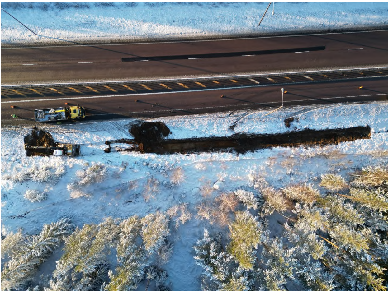
Kuva 8 Kunnostusalue ylhäältä katsottuna. Osa ojasta on kaivettuna ja onnettomuusalueen kaivaminen on käynnissä. Kuva otettu 9.12.2024.
