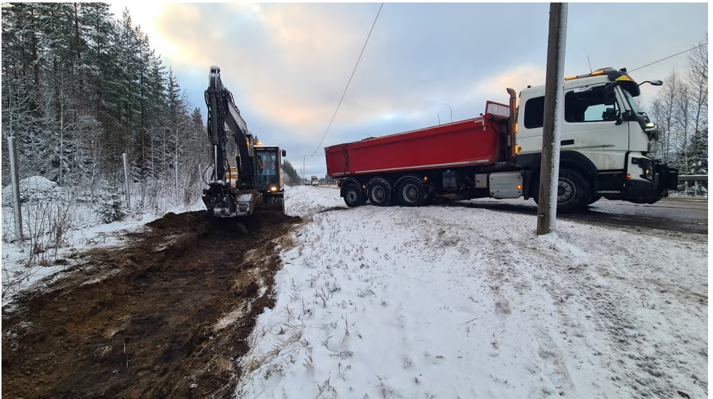
Kuva 2 Maat kaivettiin suoraan kuorma-auton lavalle. Kuva otettu 9.12.2024.
