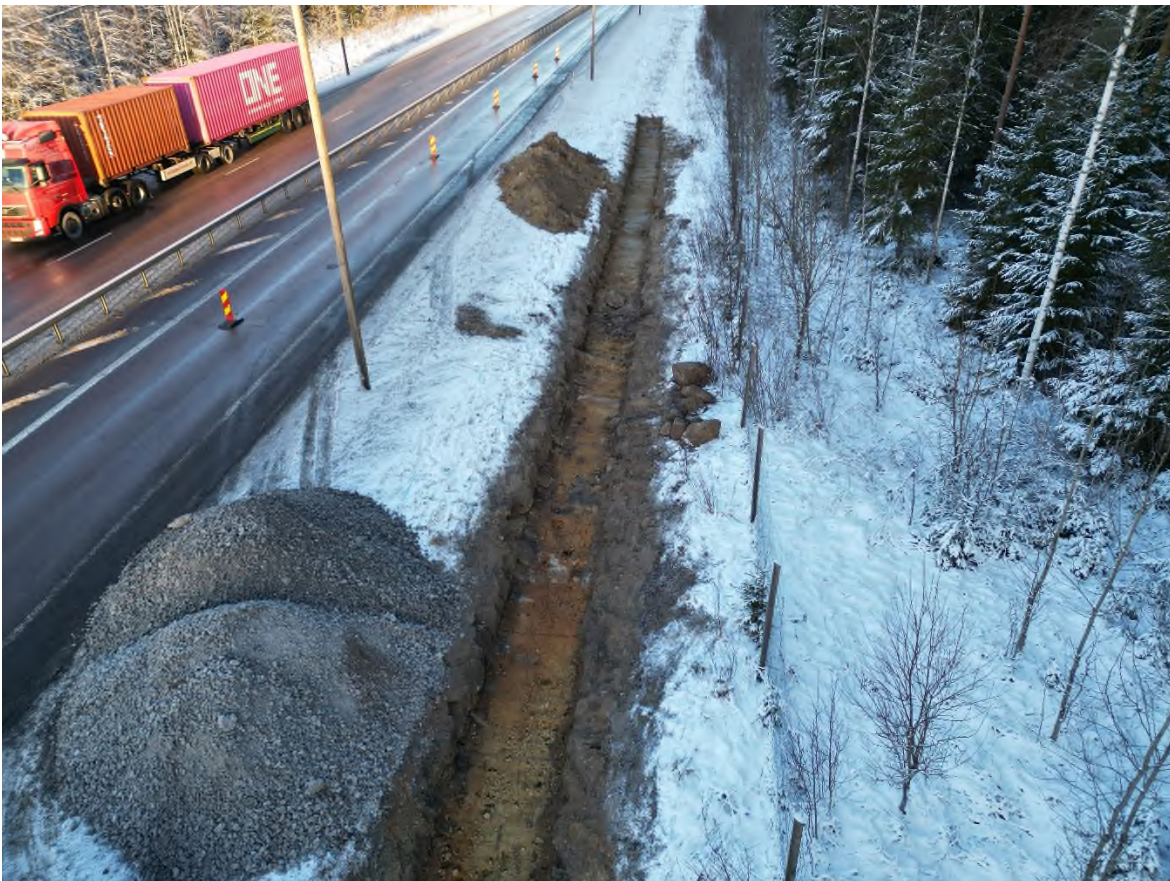
Kuva 4 Ojan alue kaivettu kokonaisuudessaan. Alueen reunoille tuotiin täyttöön käytettäviä louheita odottamaan.
