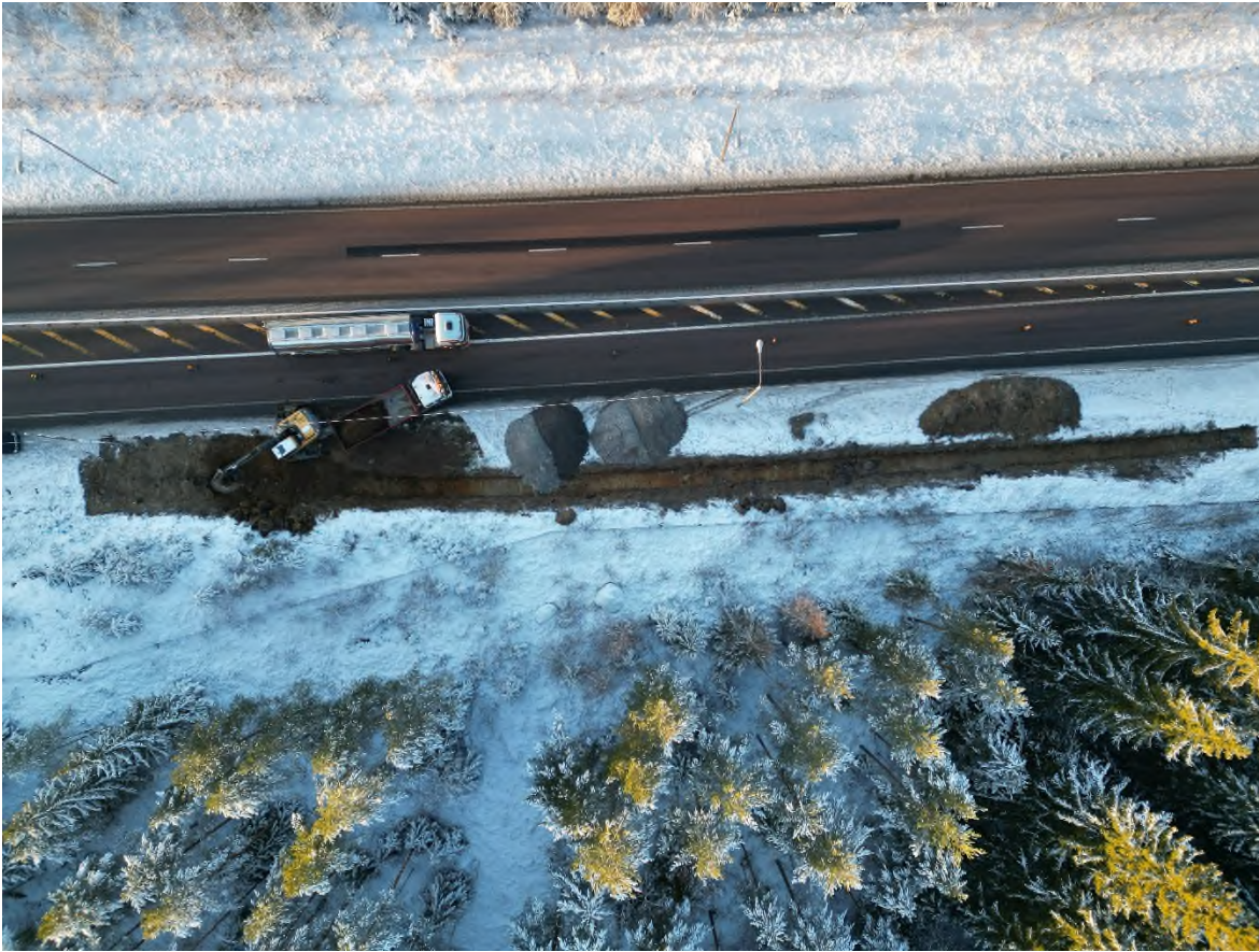
Kuva 9 Ojan alue kaivettu kokonaisuudessaan ja onnettomuusalueen kaivaminen käynnissä. Kuva otettu 10.12.2024.
