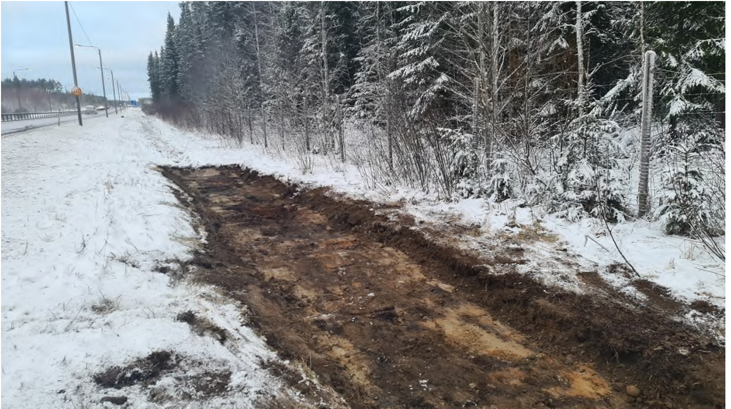
Kuva 1 Ojan alueen kunnostaminen käynnissä. Kuva otettu 9.12.2024.
