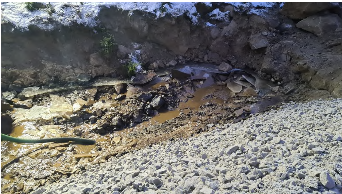
Kuva 6 Kaivannon vesien pumppaaminen käynnissä. Kaikki öljyiset vedet saatiin imettyä pois. Kuva otettu 13.12.2024.
