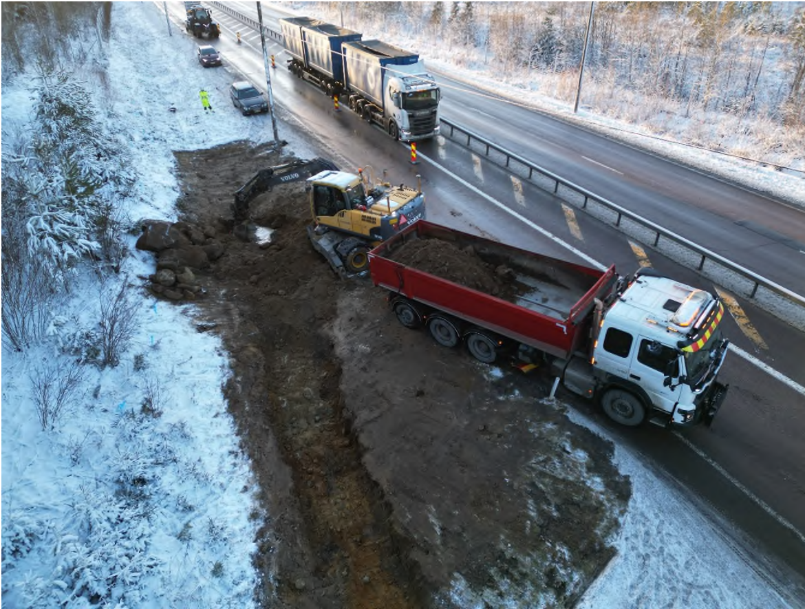
Kuva 3 Onnettomuusalueen kaivannon kaivuutyöt käynnissä. Kuva otettu 10.12.2024.
