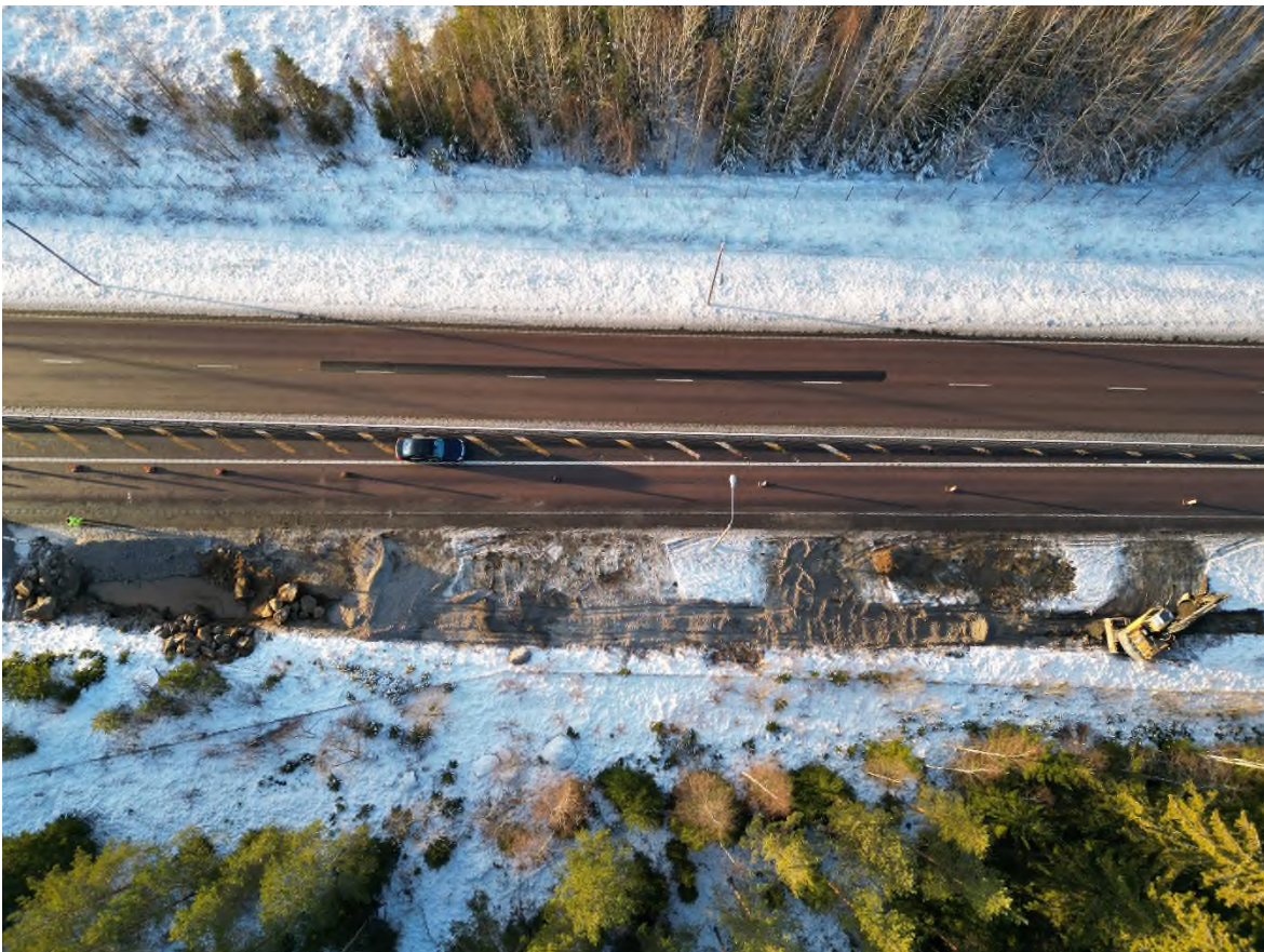
Kuva 10 Kunnostusalue lähes kokonaisuudessaan kaivettuna. Ojan alueen täyttäminen on käynnissä. Kuva otettu 11.12.2024.
