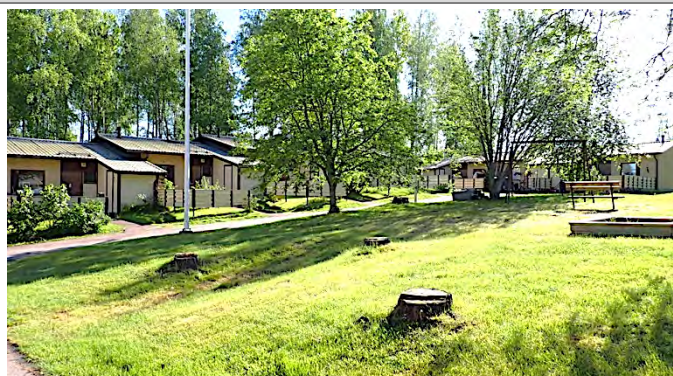
Mahlamäentie 4, kaksi rakennusta
