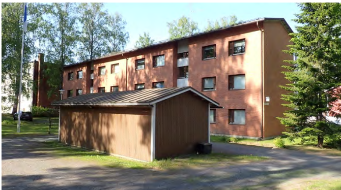
Metsolantie 20, julkisivu pohjoiseen
