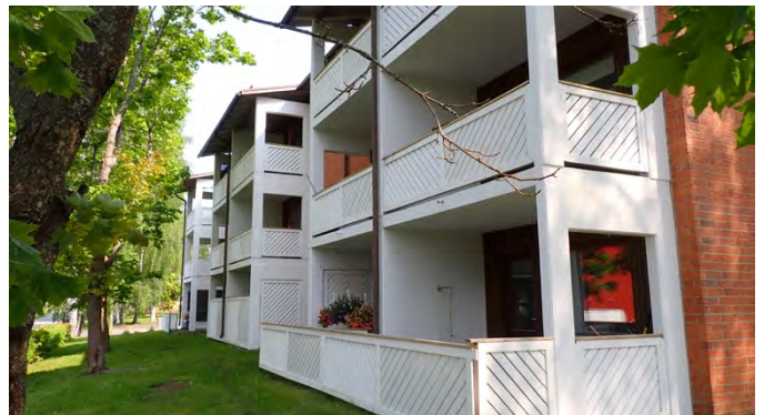
Metsolantie 20, julkisivu etelään
