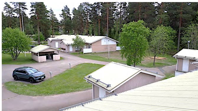
Rakennukset pääosin alkuperäiskunnossa
