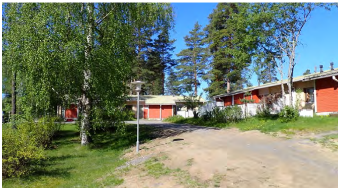
Kiinteistöllä kaksi asuinrakennusta
