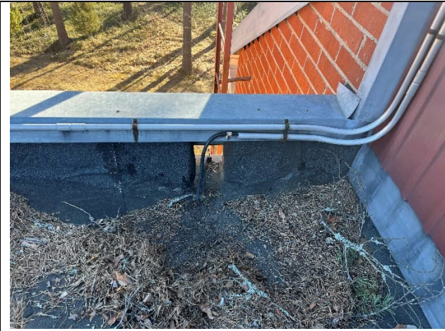
Kuva 1: Ulosheittäjä/lotokka, vedenpoisto rakennuksen ulkopuolelle
