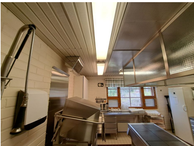
Yleiskuva keittiö, alaslaskut metalliritilöitä
