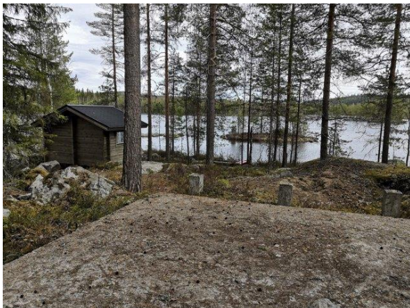
Keskeneräinen rakennuspaikka Tohtaanjärvellä
