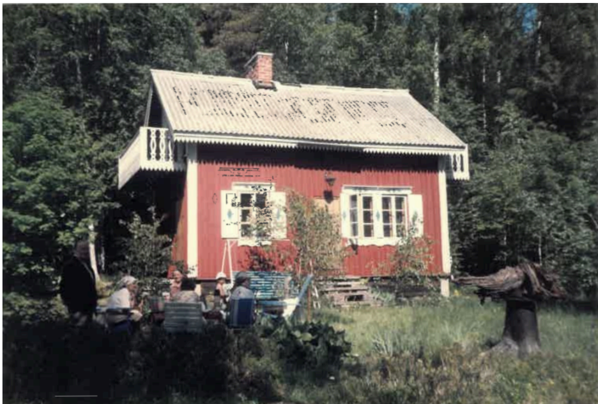
Kuva: Hiekkamäen torppa Jorma Virtasen uudelleen rakennuksen jälkeen.
